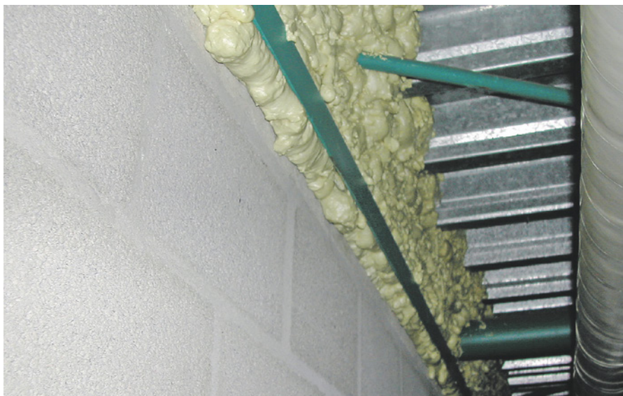
▲ Hier gaat het fout. Brandwerende purschuim is nooit geschikt bij staaldak-wandovergangen en/of doorvoeringen met metalen elementen. Uit Essentiële Bouwkundige Controlepunten.
